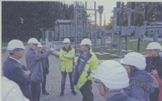
Vertreter der Kommunen sowie interessierte Besucher und Anlieger wurden fachmännisch durch die Anlage des 110-kV Umspannwerkes Tann geführt und über die Arbeitsweise der Anlage aufgeklärt. Foto: Franke
