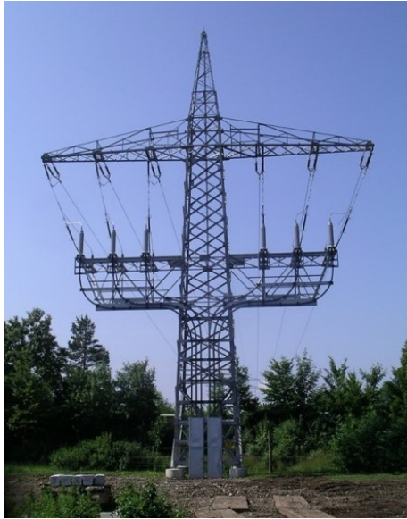
Abbildung 2: Beispiel eines Kabelübergangsmastes
